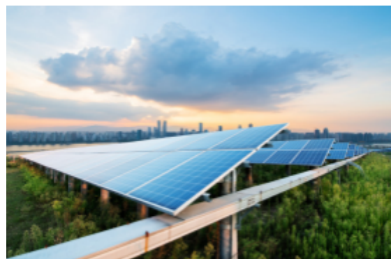
Figura 29. Panells Solars Fotovoltaics. De: ¿QUÉ ES LA ENERGÍA SOLAR FOTOVOLTAICA? (izquierdovazquez.es)
