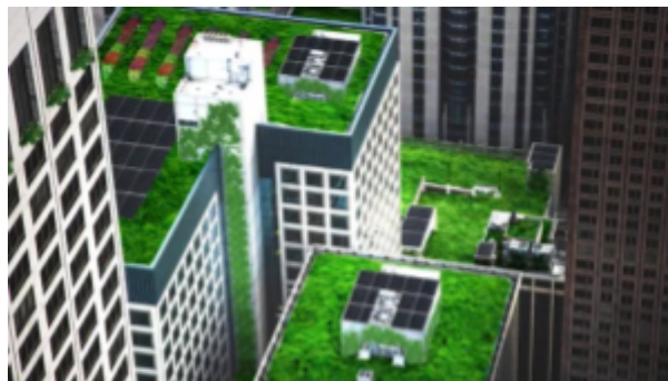
Figura 35. Teulades verdes. De: La construcción del futuro será industrializada, sostenible y circular (lavanguardia.com)
