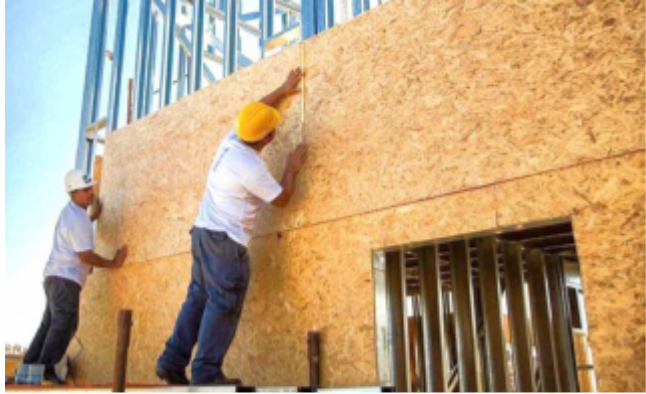
Figura 9. Panells OSB. De: Características y usos de los tableros OSB - DryWall S.A. (drywall-sa.com.ar)
